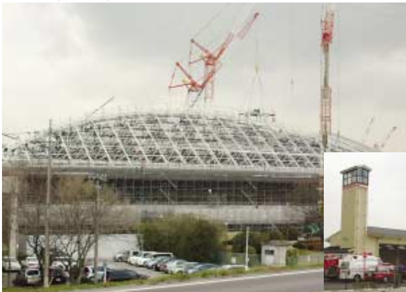
新体育館(工事中)平成19年3月完成予定
