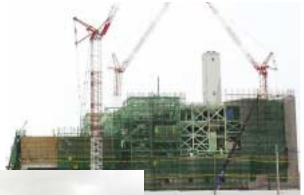
新清掃工場(工事中) 平成19年3月完成予定
