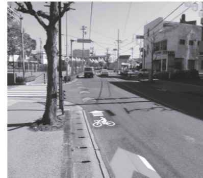
自転車通行空間(矢羽根型路面表示)の整備
