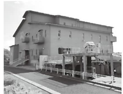
中部第3ポンプ場
