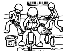
上水道や下水道の整備
